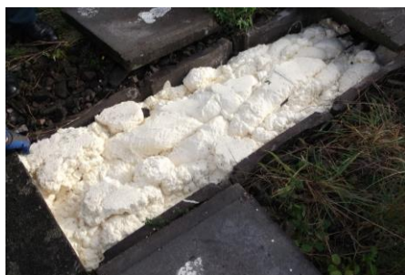
Ancrage de câbles en caniveau
