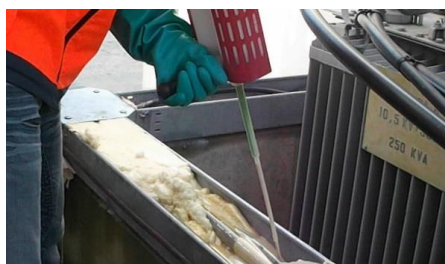
Injection en goulotte métallique
