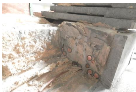
Ancrage de câbles en caniveau
