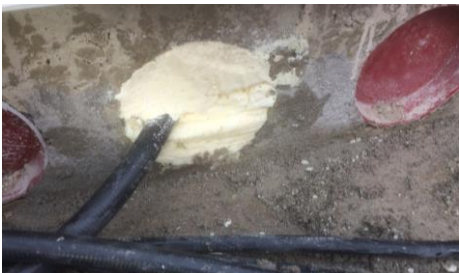
Fourreaux protégés par COVERSOL®
