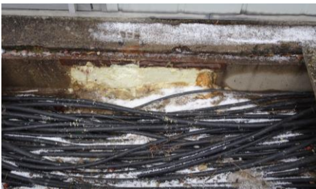
Entrées de câbles protégées par COVERSOL®
