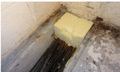
Fourreaux protégés par COVERSOL®
